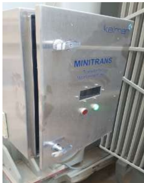
شکل 4: دستگاه مانیتورینگ پیوسته ترانسفورماتور واحد اشکودا
